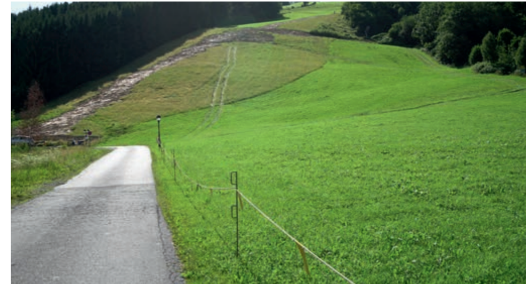
Abb. 55: Unmittelbar angrenzend an die Aufnahmefläche wurde eine Künette zur Verlegung von Infrastrukturleitungen gegraben und die Wiesenflächen extensiver bewirtschaftet (weniger Mahd, weniger Düngung). In diesen Bereichen ist die Biozönose noch deutlich diverser.
